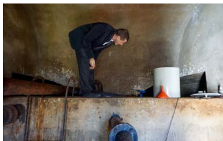
Ein Schweizer Experte besichtigt in der kroatischen Gemeinde Fužine das bestehende Trinkwasserreservoir, das 1960 erbaut wurde. © SECO
