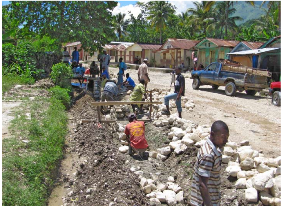
La reconstruction permet également d'améliorer les conditions d'hygiène : construction d'un canal pour l'évacuation des eaux usées.
