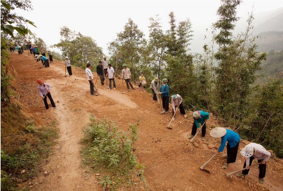
Gemeinsamer Bau einer Zufahrtsstrasse zu einem Dorf
