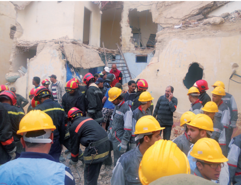
Einsturz von Häusern in Fes, Marokko, gemeinsamer Einsatz der freiwilligen Einsatzkräfte und des Zivilschutzes im Oktober 2010. Quelle: A. Dahmani
