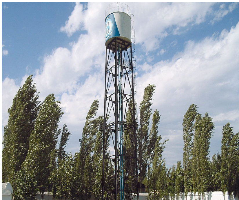
Zur Infrastruktur, die in den Dörfern neu gebaut wird, gehören auch Wasserspeicher wie dieser im Dorf Kalainow.
