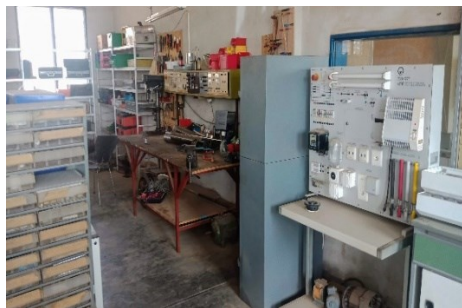
Salle de formation pratique des électriciens bâtiment : Liweitari, Natitingou © DDC Benin
