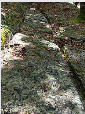
Voies à ornières de Vuiteboeuf, canton de Vaud : les deux rainures parallèles creusées dans le sol rocheux assuraient le guidage des roues des chars et empêchaient ainsi un renversement de la cargaison lors du freinage. Ces voies à ornières longtemps attribuées aux Romains datent en fait des XIII e et XIV e siècles. © DFAE, Présence Suisse
