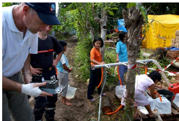
Una delle priorità dei membri del Corpo svizzero di aiuto umanitario inviati in Indonesia dopo lo tsunami è stata garantire alla popolazione accesso all'acqua potabile. ©DSC
