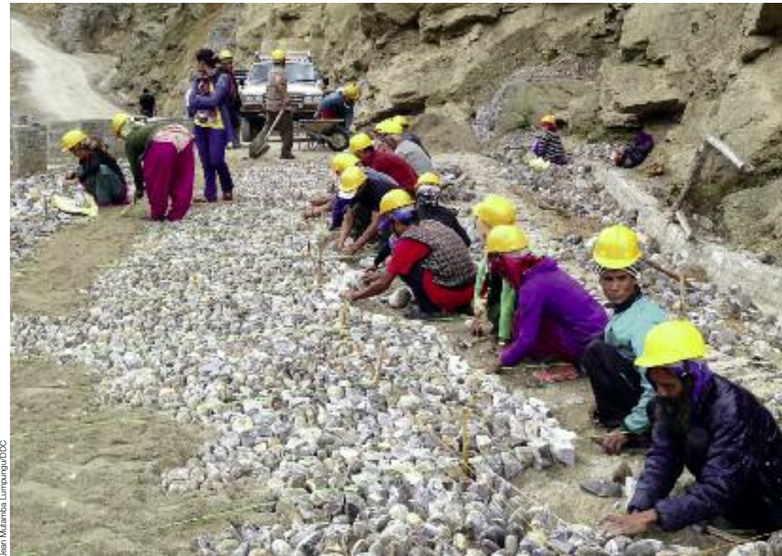
Les villageois sont associés à la réalisation d'une route. Ils participent aux décisions ainsi qu'à la construction et se chargeront plus tard de son entretien.
