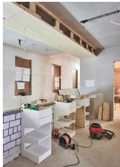
Innenausbau Einbau der Schalterbereiche
