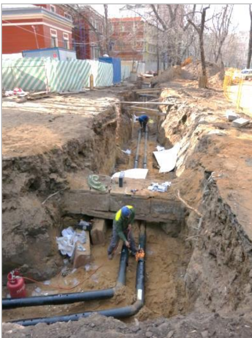
Einbau der Fernwärme Erschliessungsleitung
