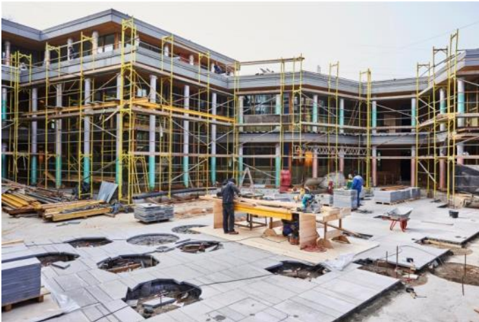
Arbeiten im Innenhof Verlegen der Valser-Granit Platten
