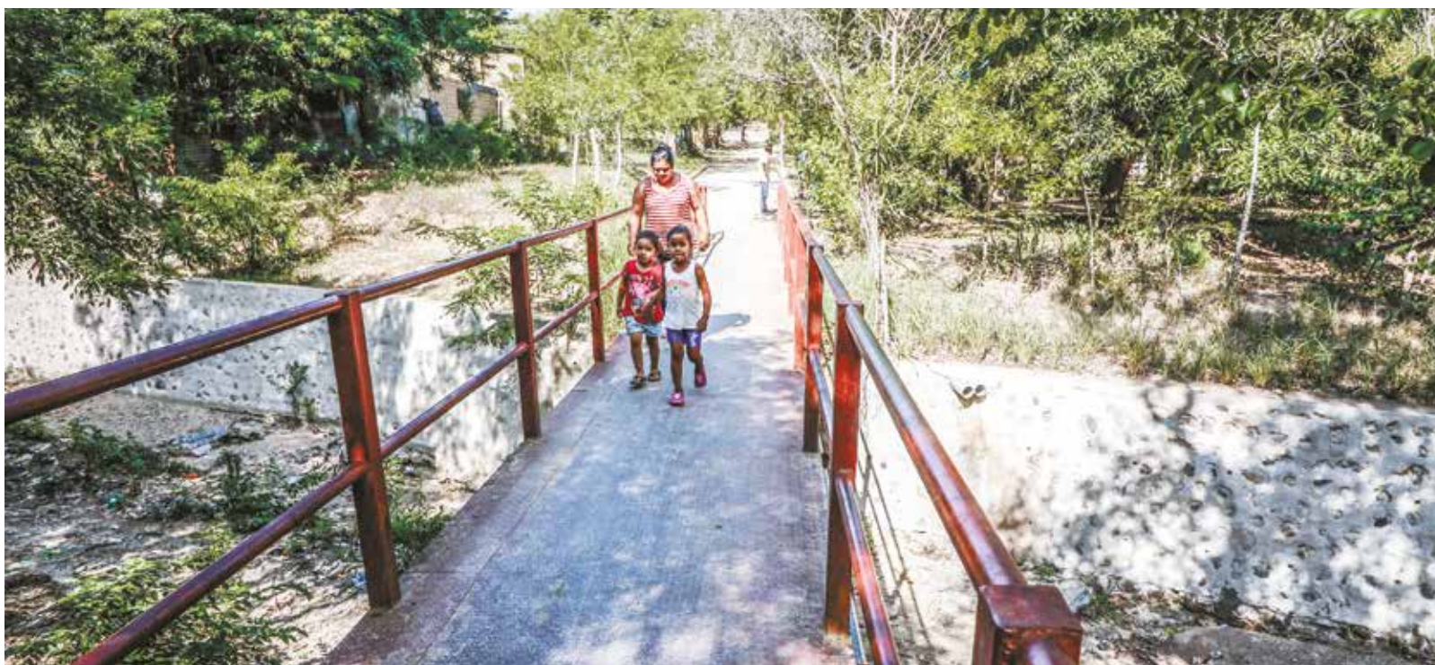
Con el objetivo de proteger el puente peatonal, se levantó un muro de contención en el barrio 19 de Julio, el cual evita deslizamientos.
