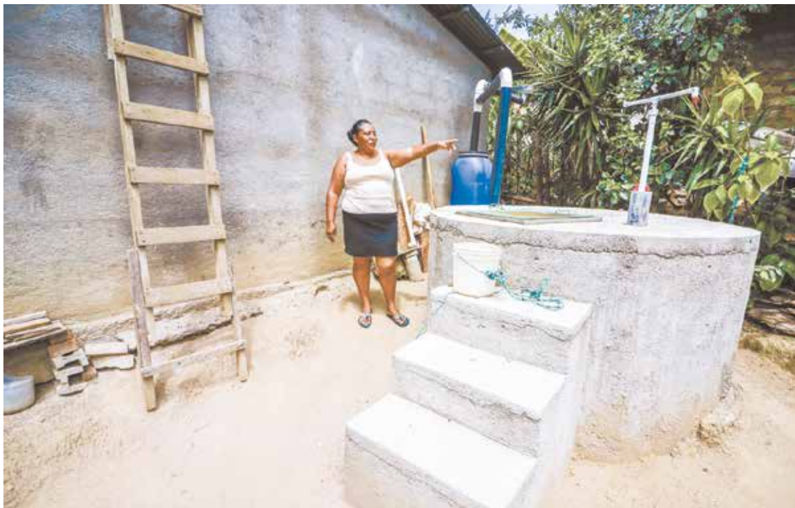
Doña Dina Martínez muestra la cisterna que construyeron en su casa para almacenar agua de lluvia.
