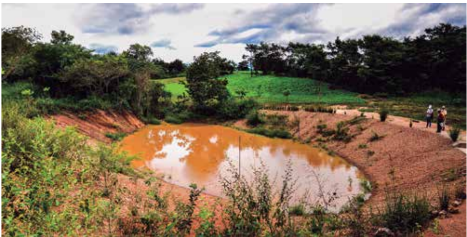
La construcción de reservorios circulares es menos caro, debido a las facilidades que ofrece para el movimiento de la maquinaria. Foto: CATIE.
