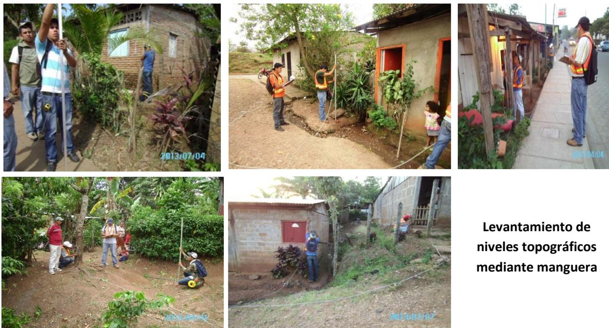
**Levantamiento de niveles topográficos mediante manguera**
