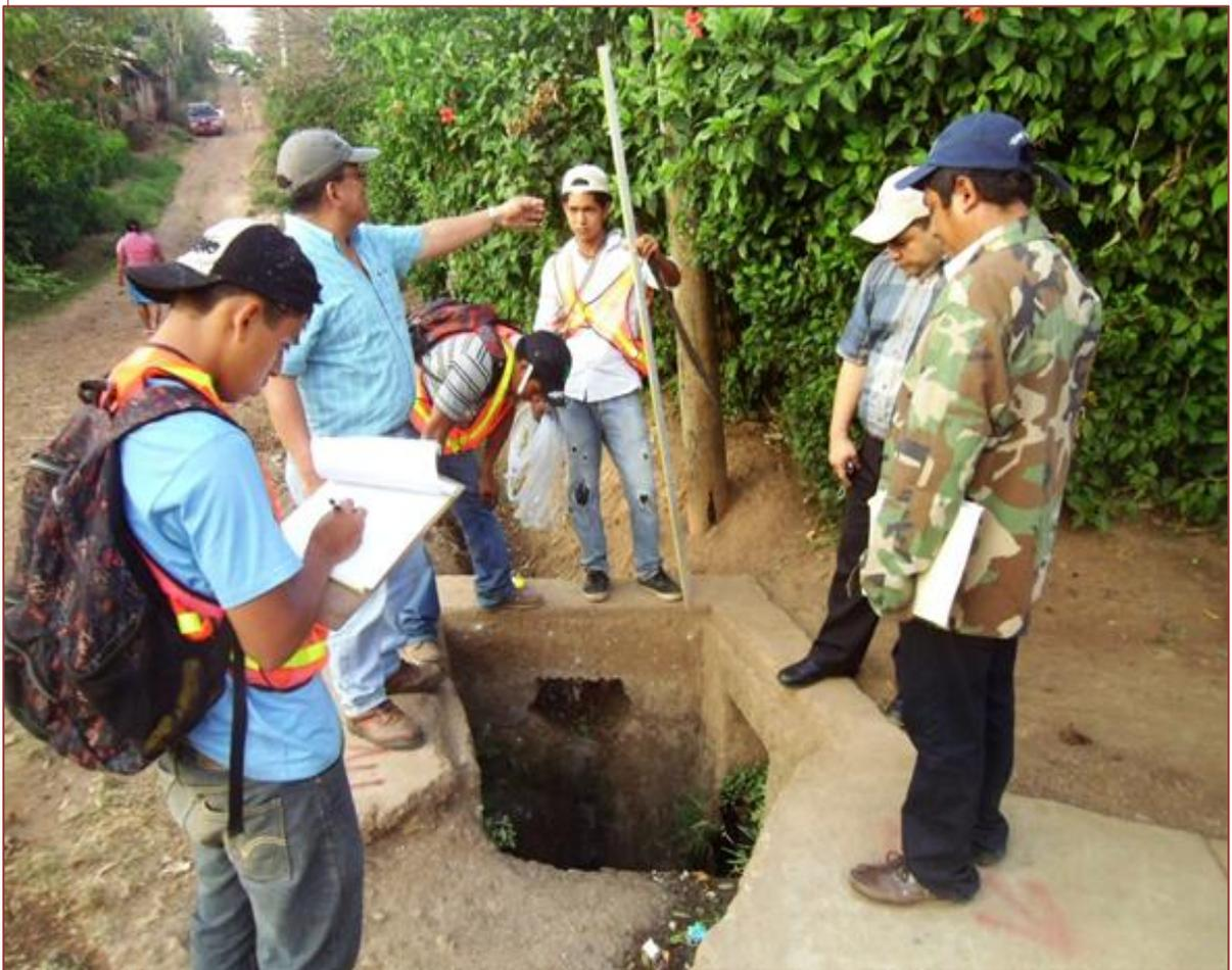
**Identificación de obstáculos ubicados en el trazado de la Red de Alcantarillado Condominial y levantamiento de niveles.**
