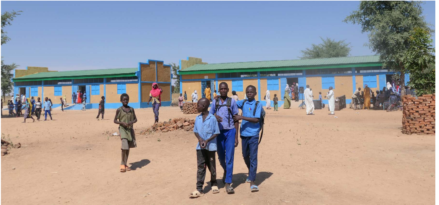
Ecole Dar Alhadjra, Sous-préfecture de Koundjourou
