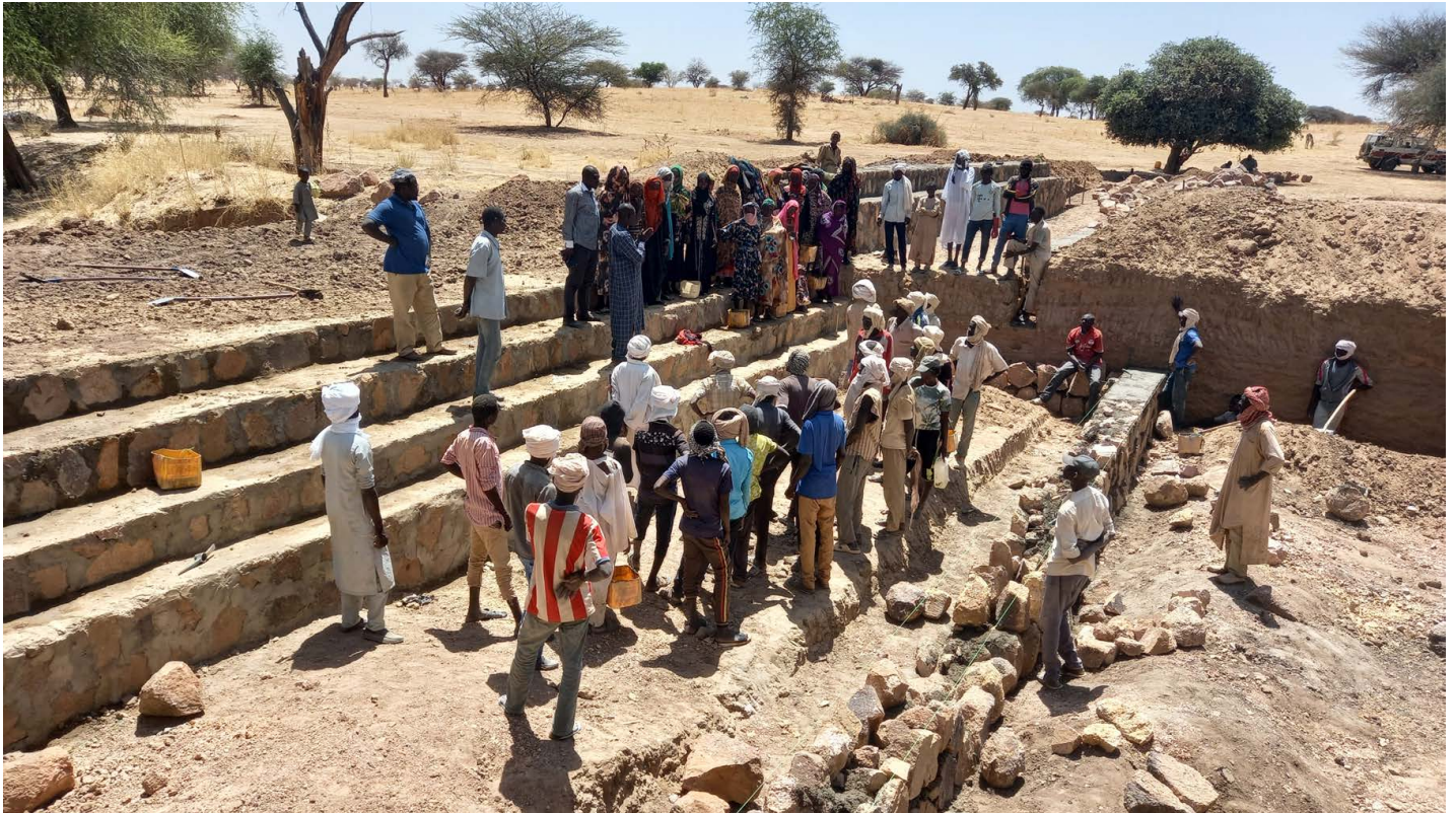
Une communauté en pleine construction d'un seuil d'épandage.
